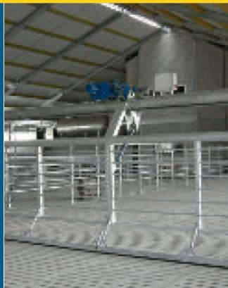
Het heavy duty Auto Mate opdrijfhek is ontworpen voor veelvuldig en intensief gebruik. Voorzien van een sterke perslucht of klimaatbestendige hydraulische bediening, geheel op maat vervaardigd. Leverbaar met diverse opties zoals geautomatiseerd opdrijven en mestschuiven.
