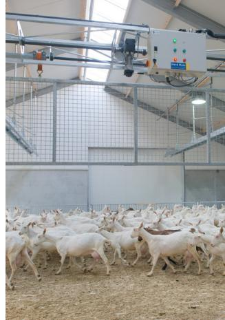
Geiten- of schapenmelk-stal met zwevende pootloze constructie voorzien van grijze kunststof panelen en veerloze RVS scharnierpennen. Hefmechaniek voorfront met een trekbuis en rollenkettingen. Leverbaar met grote voerbakjes en toepasbaar met diverse voer doseersystemen.
